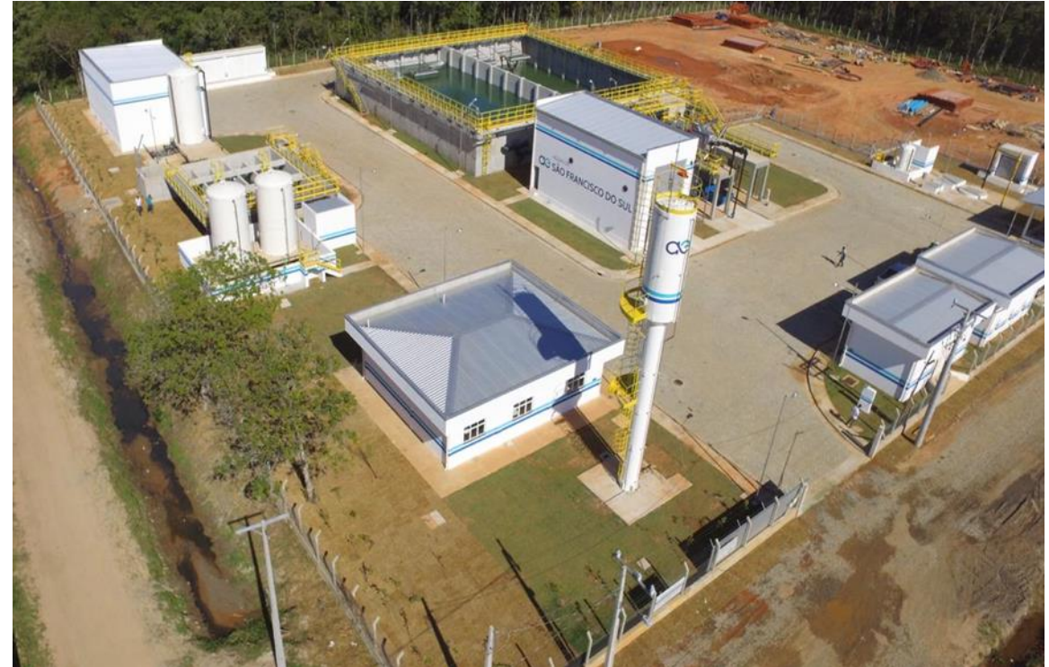
ETE São Francisco do Sul
